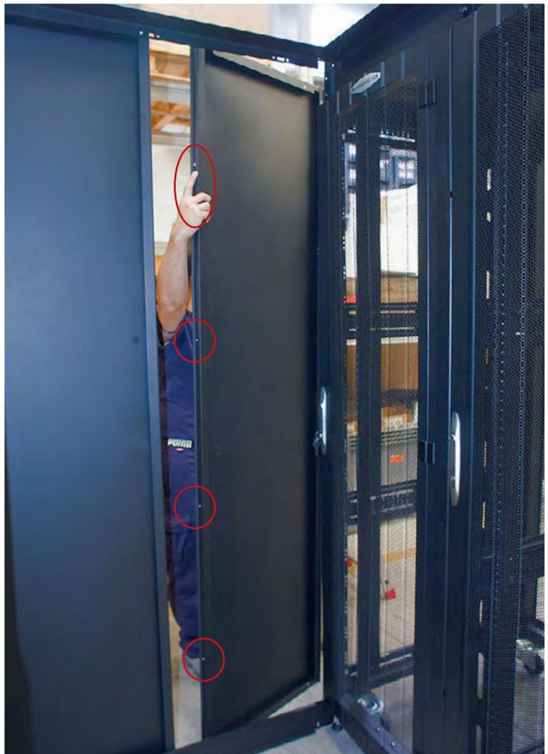
Inserire il carter centrale dall' esterno. Fissarlo dall' interno con le viti frontali sulla traversa <sup>1</sup> e dall' esterno con 4 viti da accoppiare i dadi in gabbia. Dopo questa operazione provvedere al tiraggio di tutte le viti della struttura.
